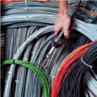
Установка термоусадочной муфты.
