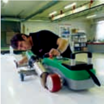
Сварка подворота аппаратом VARIANT T1.
