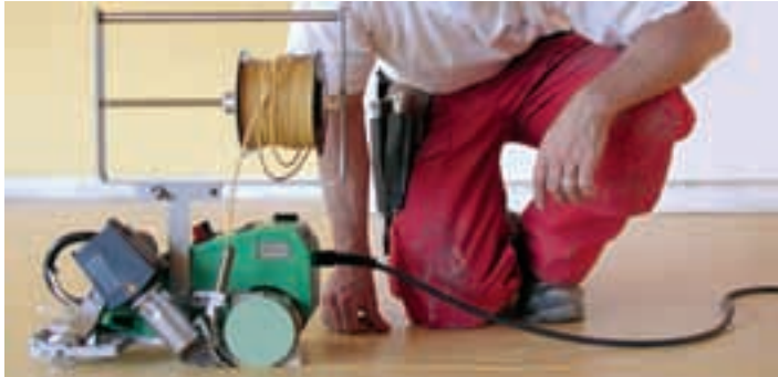
Сварка напольных покрытий сварочным автоматом Unifloor E.
