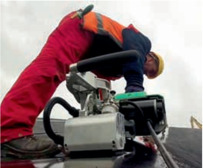
Сварка ПЭНД мембраны аппаратом GEOSTAR.
