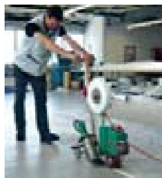
Наварка упрочняющей ленты на максимальной скорости.
