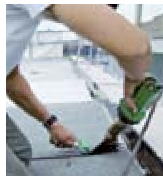
Мощный ELECTRON с широкой щелевой насадкой при сварке битумного покрытия.
