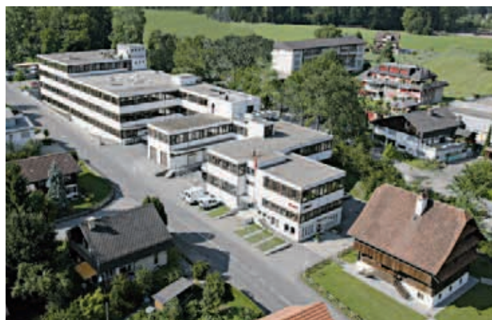
Leister Technologies AG, производственное здание, Кегисвиль, Швейцария
