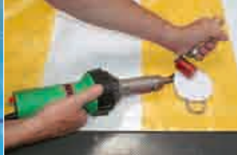
Наварка крепежной накладки при помощи ТРИАК S.
