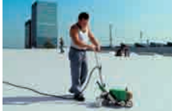
Сварочный автомат ВАРИМАТ при сварке полимерного кровельного покрытия.
