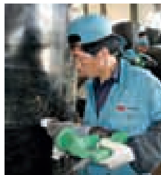
Экструдер FUSION 2 при сварке резервуара.
