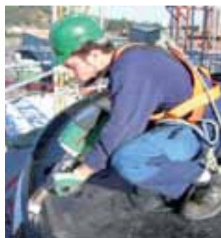
Мощный WELDPLAST S4 в работе.
