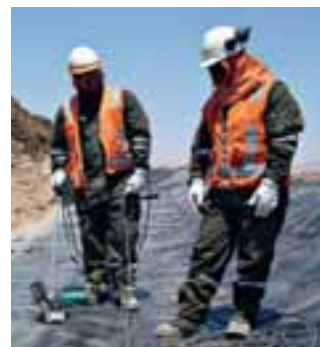
TWINNY S с комбинированным клином при сварке на одном из южноамериканских рудников.
