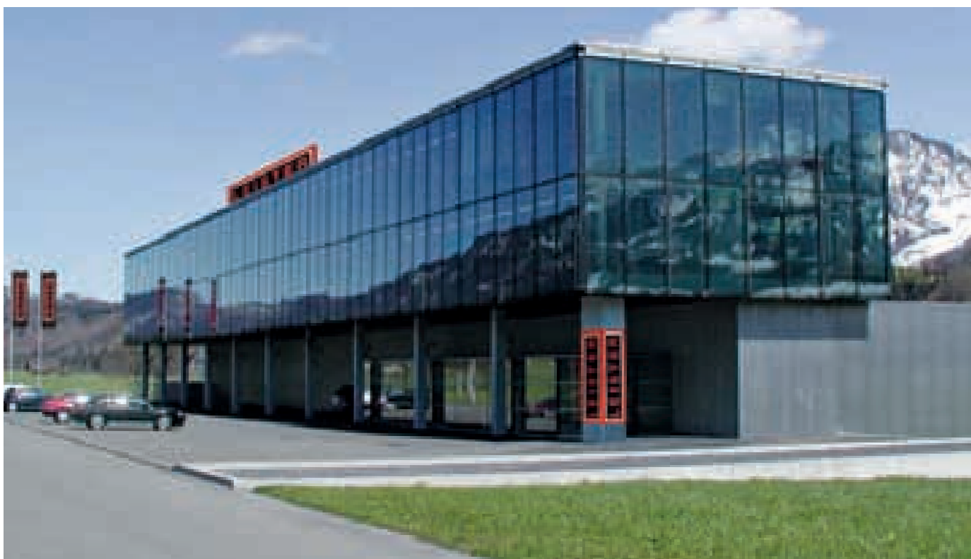
Здание корпоративного центра фирмы Leister, Кегисвиль, Швейцария
