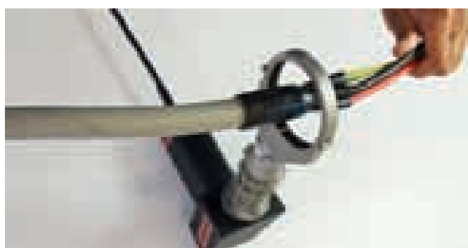
Термоусадка с помощью аппарата GIBLI
