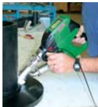
Сварка трубы аппаратом WELDPLAST S2
