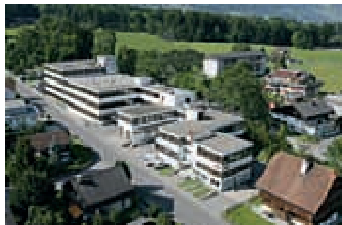
Производственные корпуса Leister Process Technologies, Кегисвиль, Швейцария
